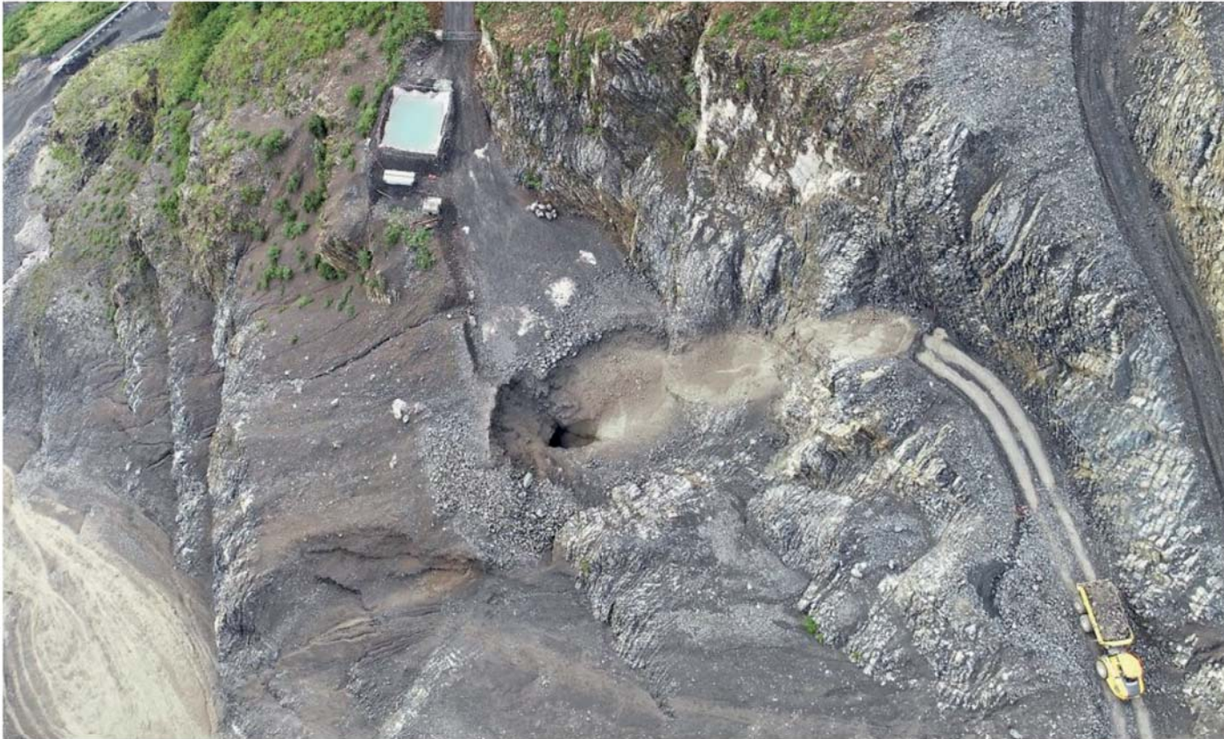
Le nouveau puits de dévalage de 286 mètres de profondeur (au centre) vise à limiter les nuisances. Il permet aux roches de ne plus rouler le long de la paroi: elles sont poussées dans cette cheminée large de 3,7 m de diamètre et s'accumulent sur la hauteur du puits. Un tunnel permet ensuite à la roche d'être évacuée. DR
